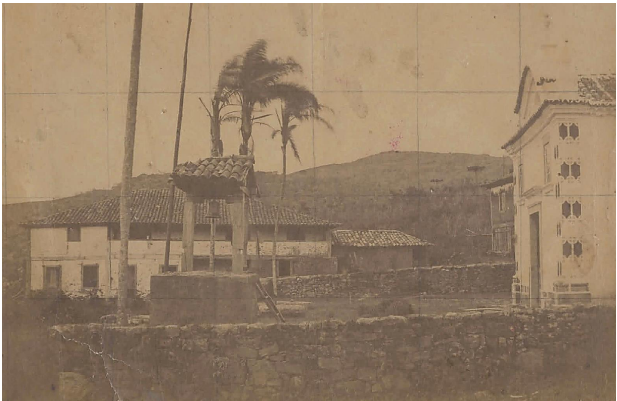
Foto da antiga Capela de Santana do Garambéu, tendo ao fundo a “Casa da Santa”, sobrado com nítidas influências arquitetônicas bandeiristas
